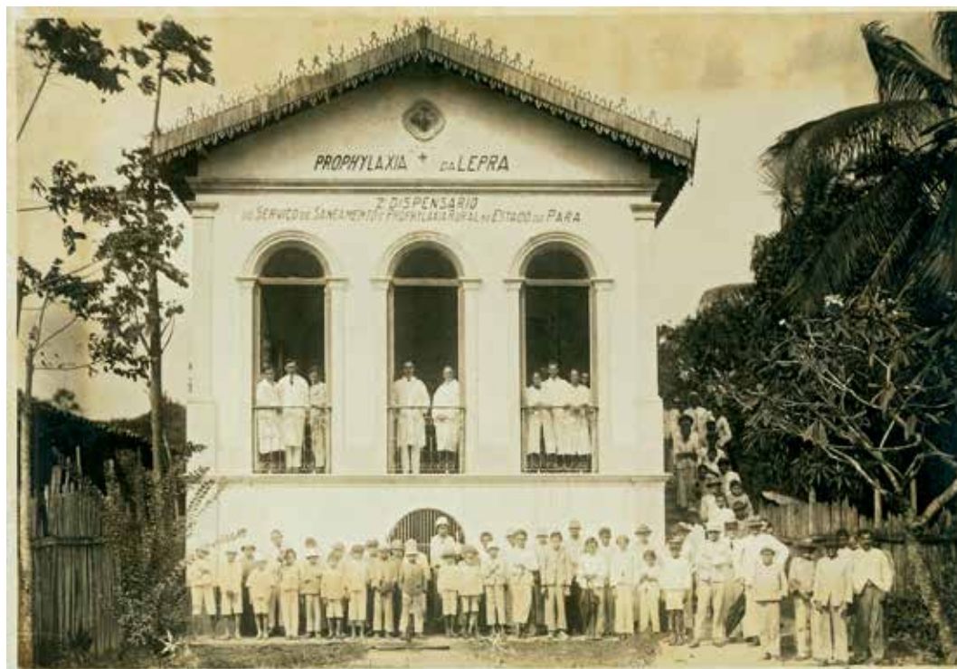
Fachada do Instituto Terapêutico da Lepra no Estado do Pará, (1920-1924). Acervo: Casa de Oswaldo Cruz - Departamento de Arquivo e Documentação
