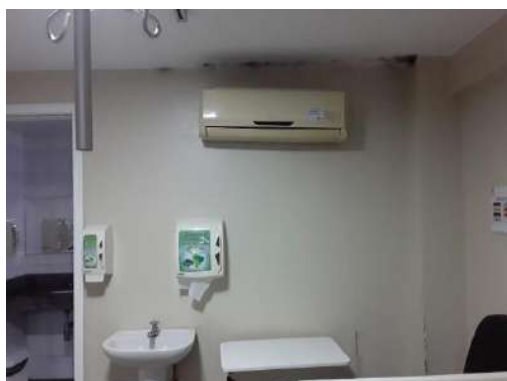
Revitalização da ENF. 512 Com substituição da Split
